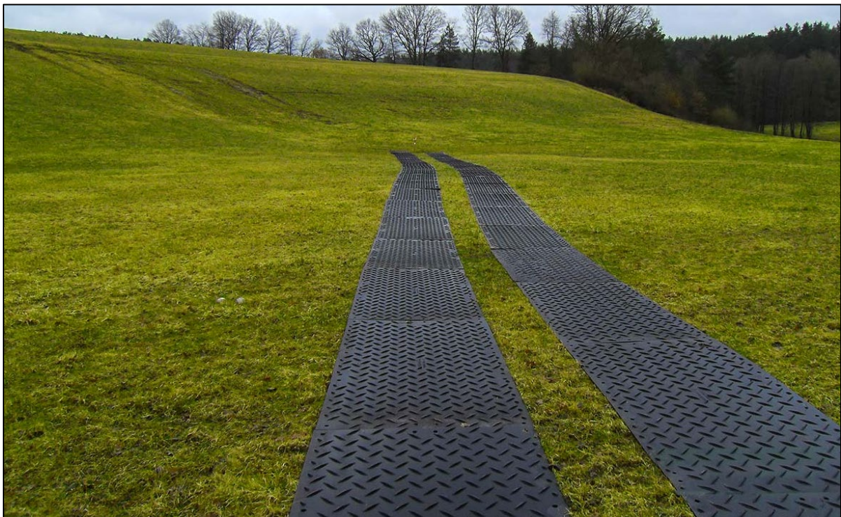
Abbildung 12: Beispielfoto mobile Baustraße zur Vermeidung von Bodenverdichtung ( https://www.securatek.de/Referenzen/s-tek-48-Hochleistungs-Bodenschutzplatte-als-Mobile-Baustrasse-beim-Rohrleitungsbau-bei-Creussen-in-Bayern )
